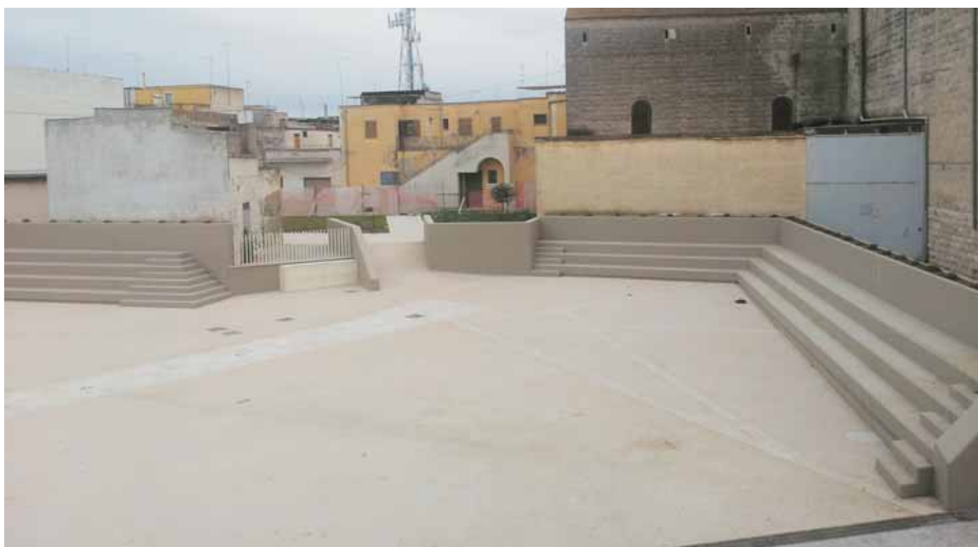
Piazza S. Stefano si riveste di grigiocemento e diventa, con il garage appoggiato alla cattedrale, un memorial alla "BRUTTEZZA".
