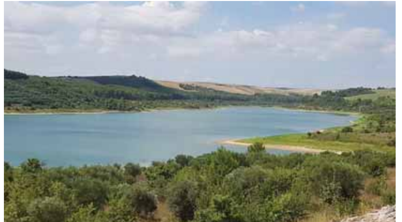
Diga Locone sul torrente Locone
