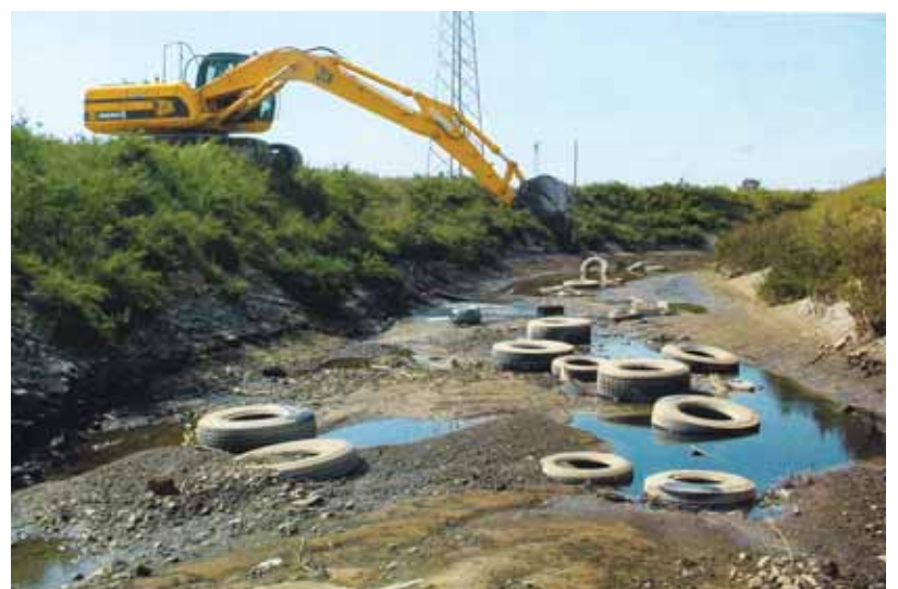
2005. Lavori per la pulizia del Canale 5 metri
